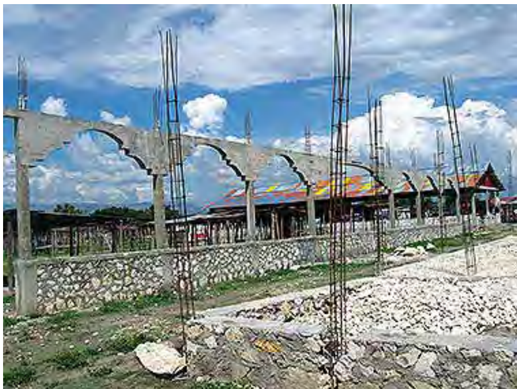
Le marché de Liancourt en construction
